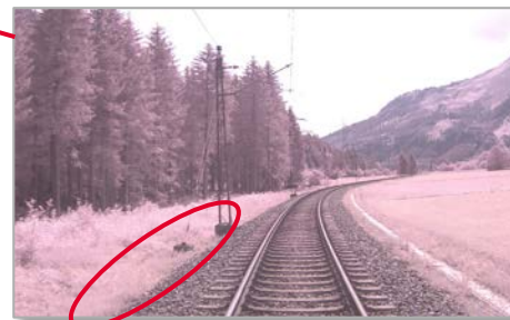
fehlende Entwässerungsgräben
